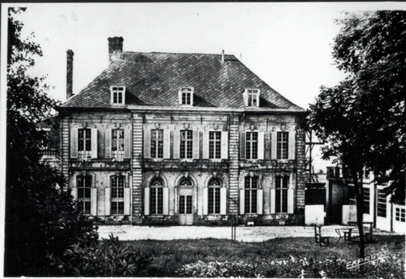
Logis abbatial côté parc (connu aujourd'hui sous le nom de Maison de repos)
